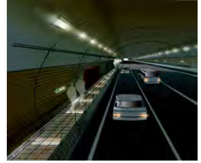
高速道路のトンネル内の非常時避難誘導システム。
