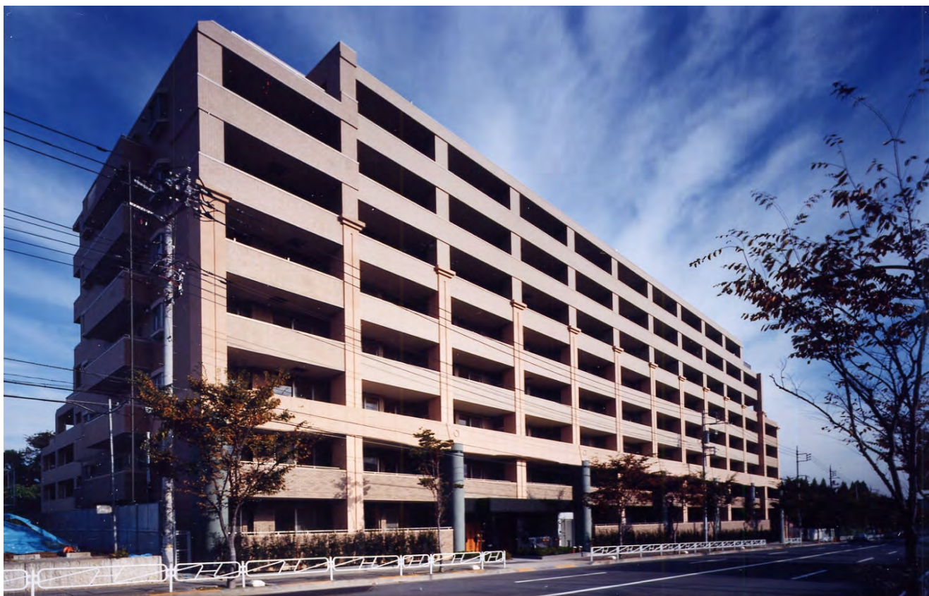
アプローチ側外観
