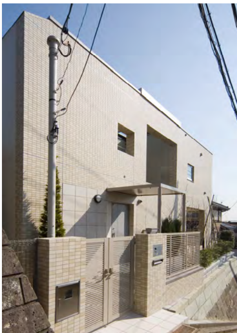
ポーチ側外観
