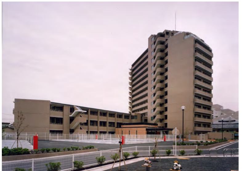
アプローチ側外観
