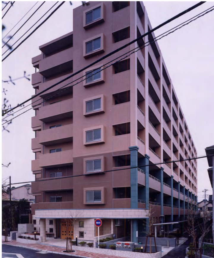
アプローチ側外観
