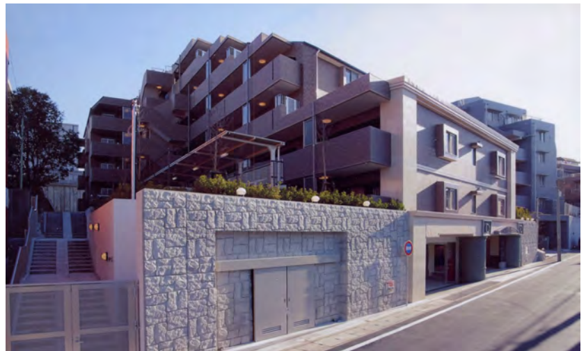
アプローチ側外観
