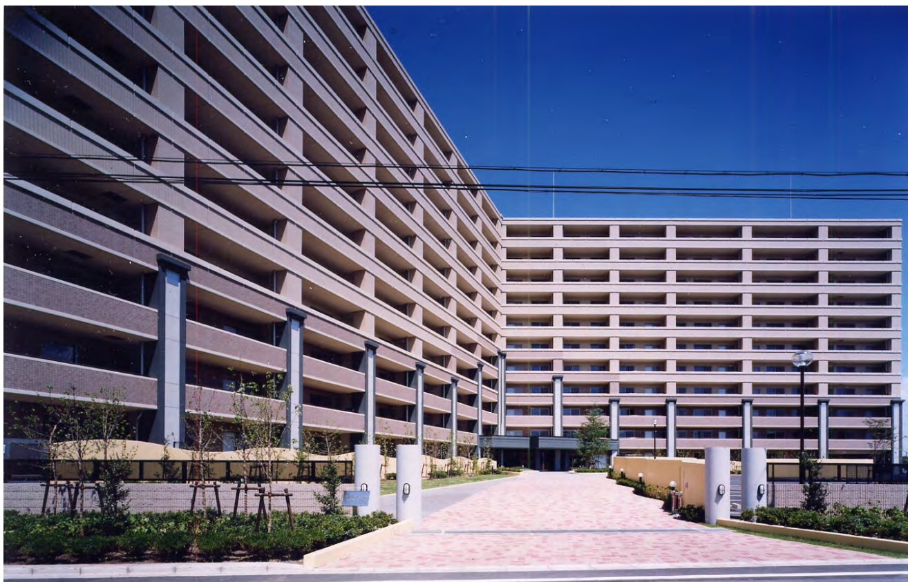
アプローチ側外観
