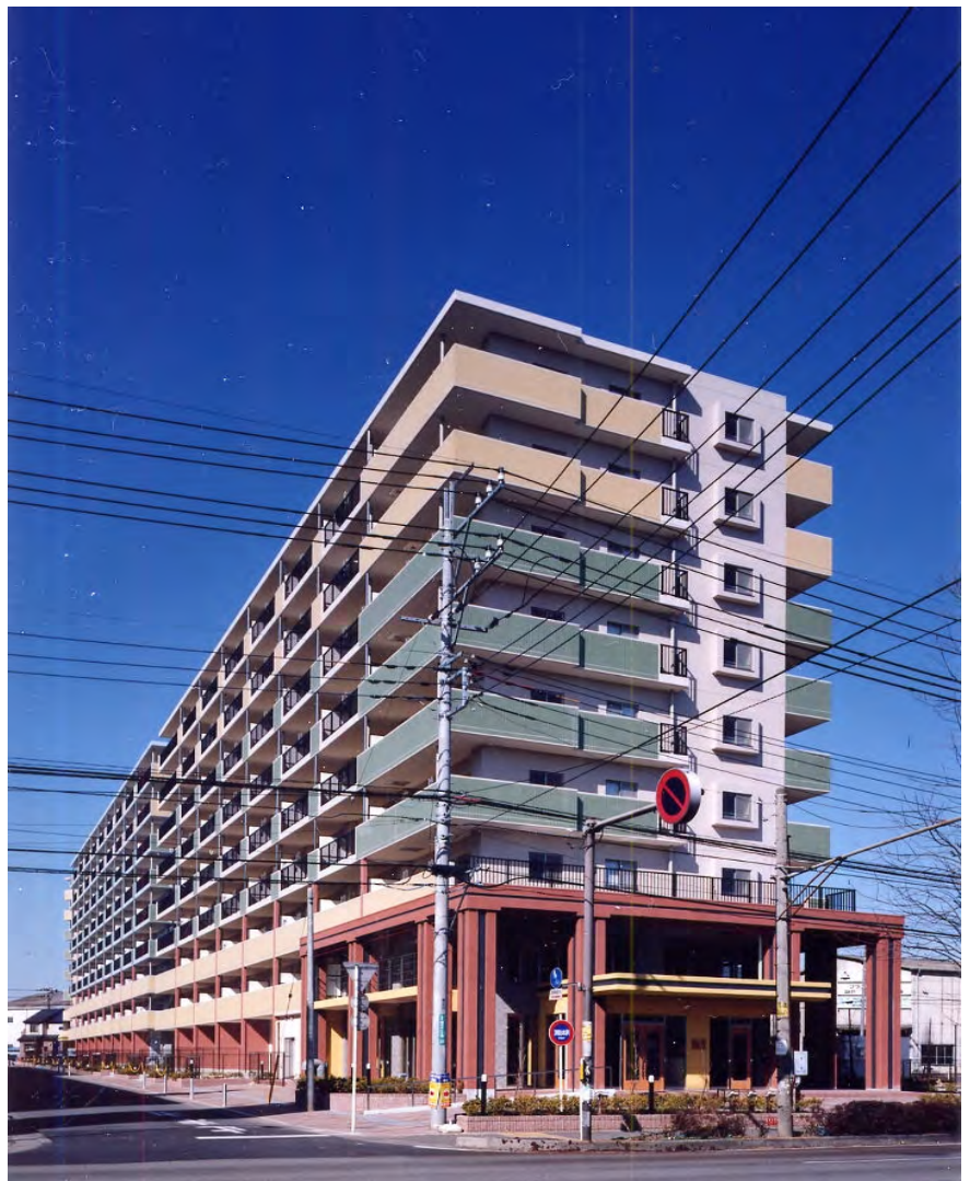
アプローチ側外観
