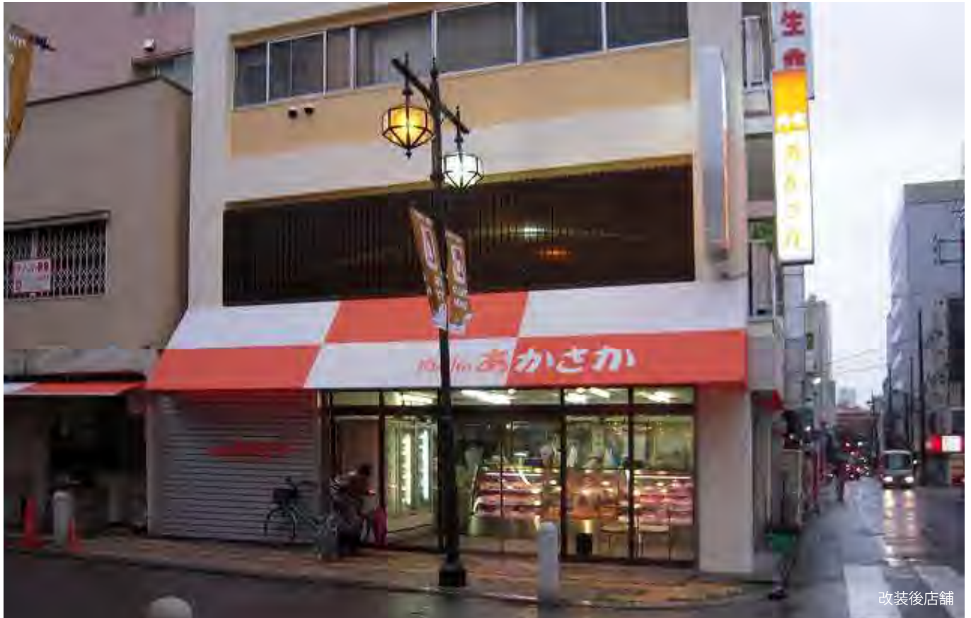
改装後店舗正面
