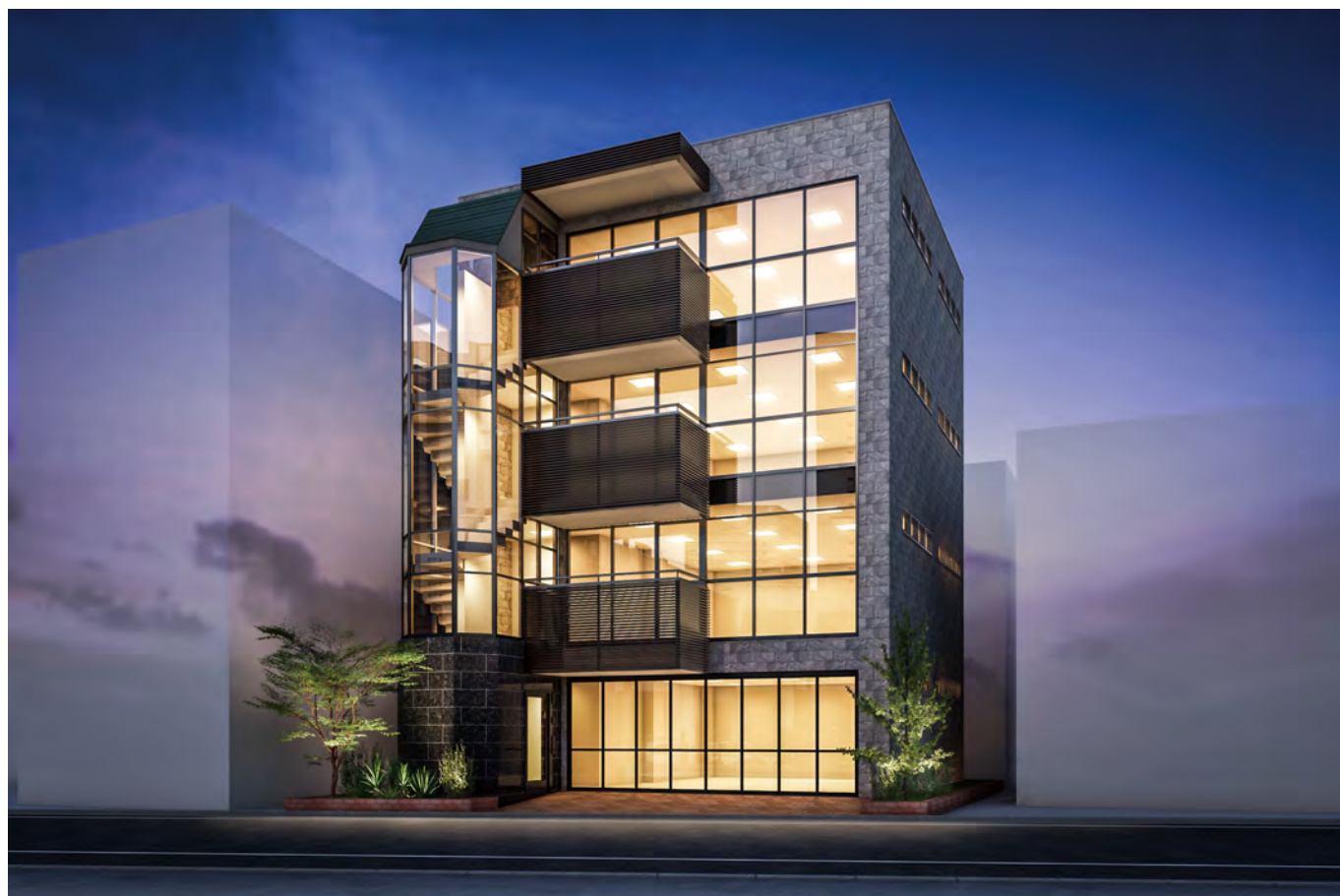
東京土建組合新宿新部会館新築計画 工事中
